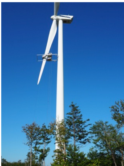
Rotorblattheizungssystem im Einsatz: Die Hamburger Firma Spitzner Engineers GmbH ist in Kanada vor Ort (Bild: SPITZNER ENGINEERS GmbH)
